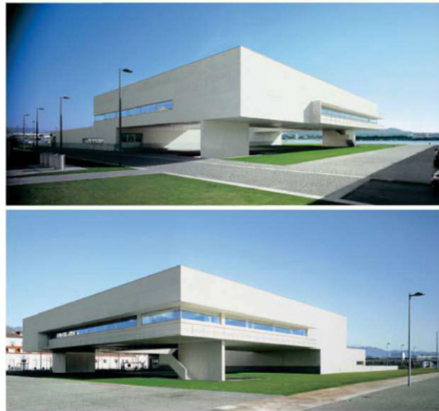
BIBLIOTECA MUNICIPAL EN VIANA DO CASTELO MUNICIPAL LIBRARY, VIANA DO CASTELO Portugal, 2001/2007 ET Croquer 140, 2008, p.170
