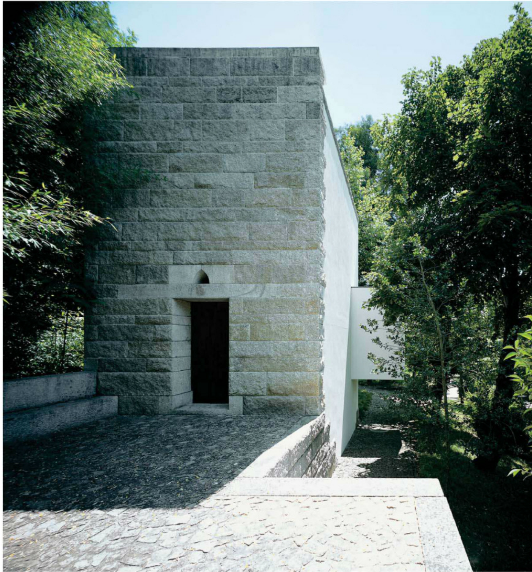
Una primitiva capilla, dedicada a San Ovidio, fue demolida por orden de un antiguo propietario. La nueva capilla, situada entre la vegetación, se alza junto a un grupo de tilos en una cota elevada del terreno del solar. La zona de sacristía se alza en voladizo sobre el cuerpo encajado de la capilla, formando el porche de entrada al espacio sagrado y precediendo a las escaleras de acceso al atrio.
